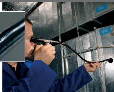
Prüfung im Klimakanal mit Schwanenhalsummantelung, mittlere Flexibilität
